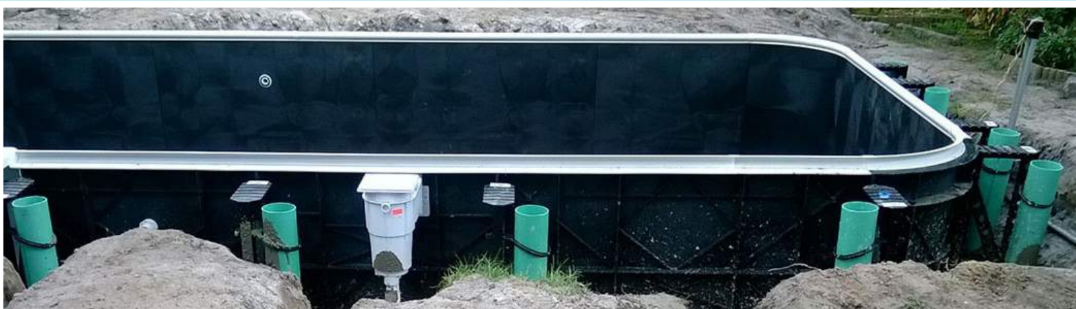
SONO TUBES PLACED AROUND POOL
